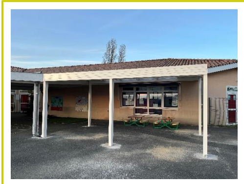
RÉALISATION DU PROLONGEMENT DU PRÉAU
